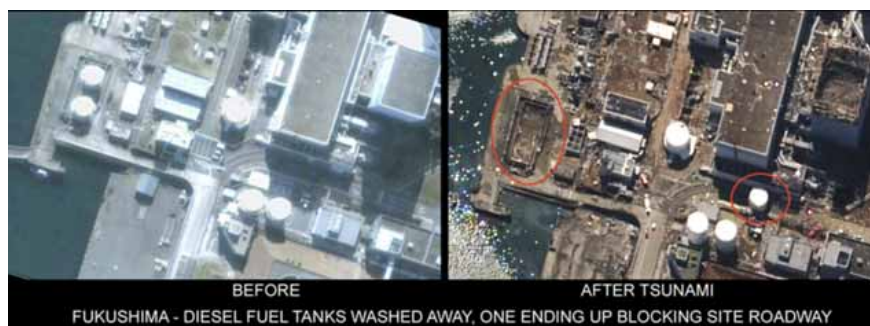
I grandi serbatoi di gasolio a Fukushima sono spazzati via e spostati a decine di metri di distanza
